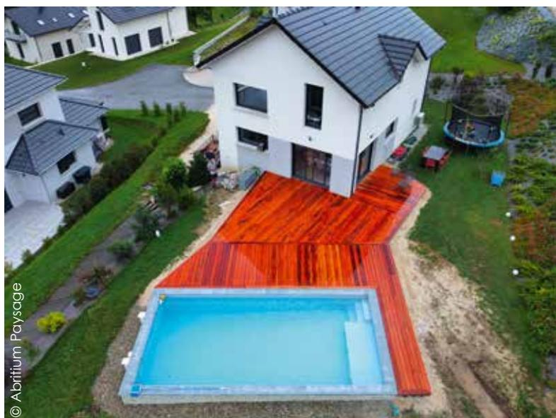
La terrasse bois a été décomposée en plusieurs parties car les arêtes de la maison et du bassin ne sont pas parallèles. Une lambourde centrale permet ainsi de faire pivoter l'orientation des lames pour qu'elles soient perpendiculaires aux éléments structurants.
