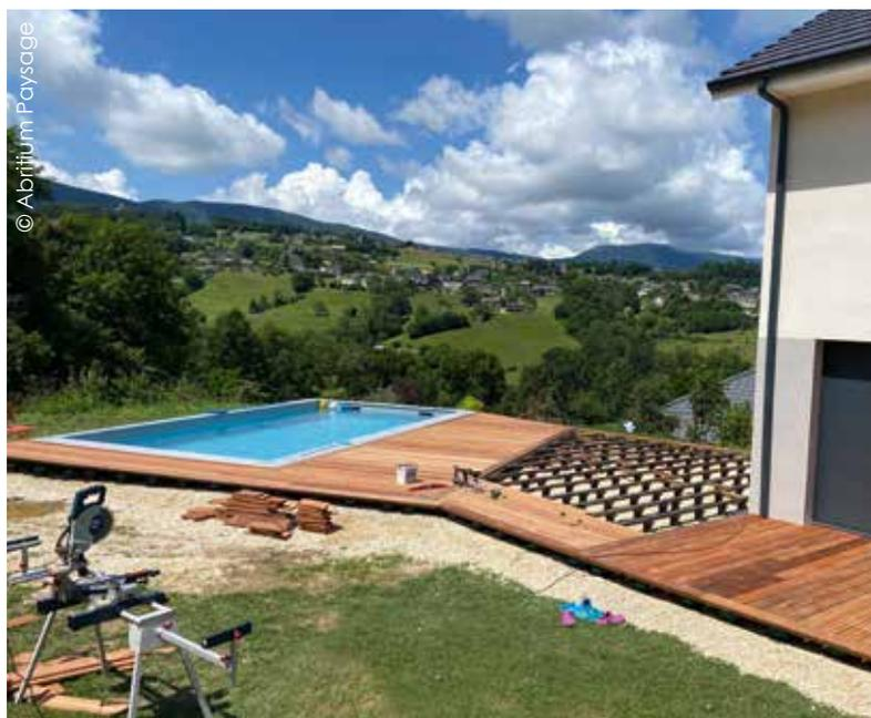
L'utilisation de bois dur nécessite d'employer des outils adaptés, tels qu'une scie à onglet avec disques et mèches spécial bois dur ou encore une visseuse à choc pour enfoncer les vis.
