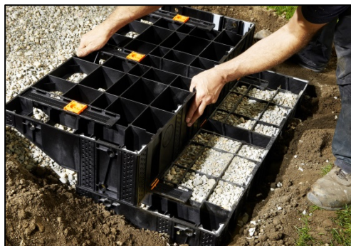
Les modules viennent se superposer en suivant la pente.
