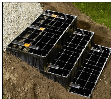
La structure de l'escalier prend vite forme.
